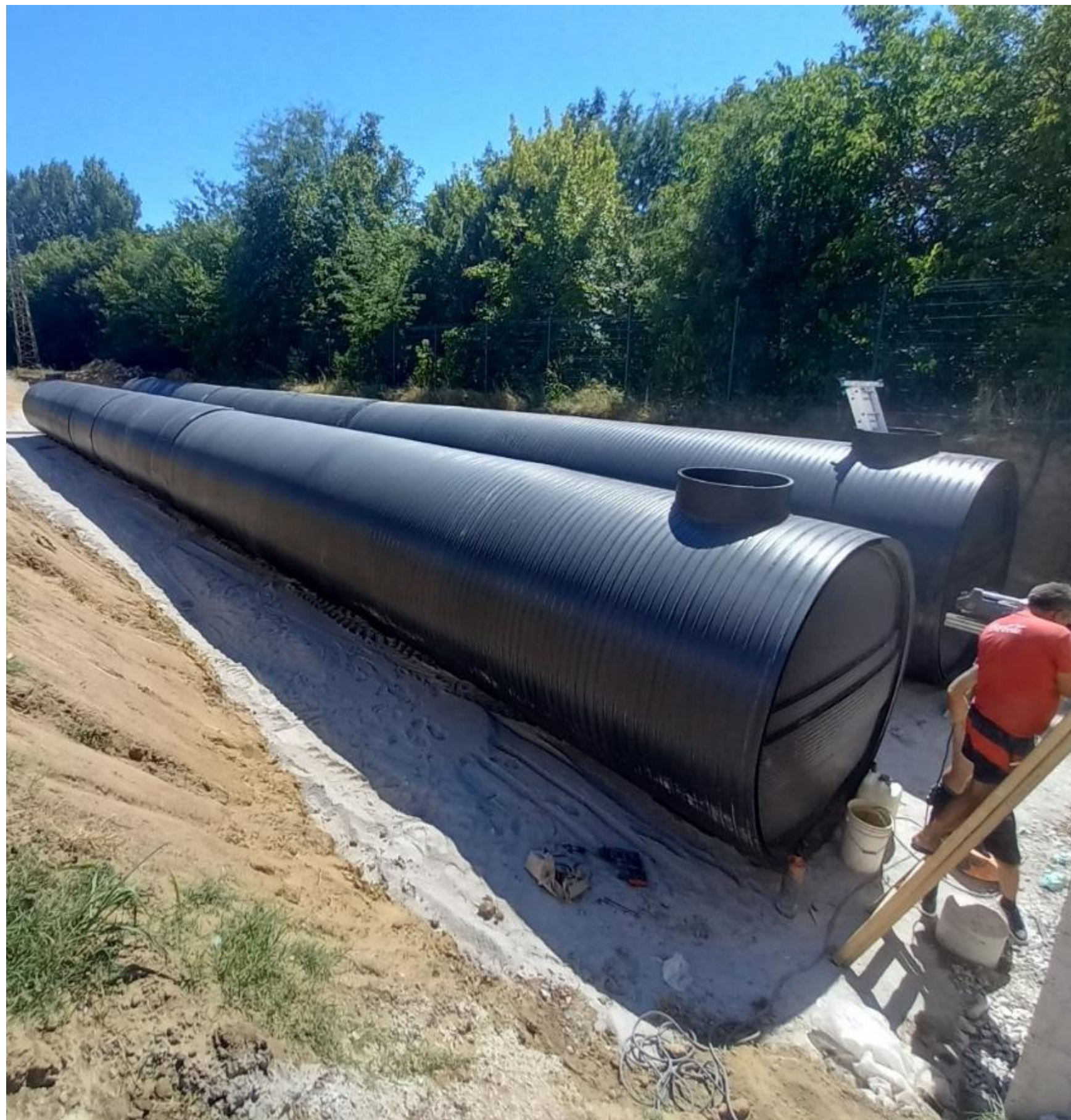
Обект: гр. Видин Резервоари за противопожарни нужди 300m 3
