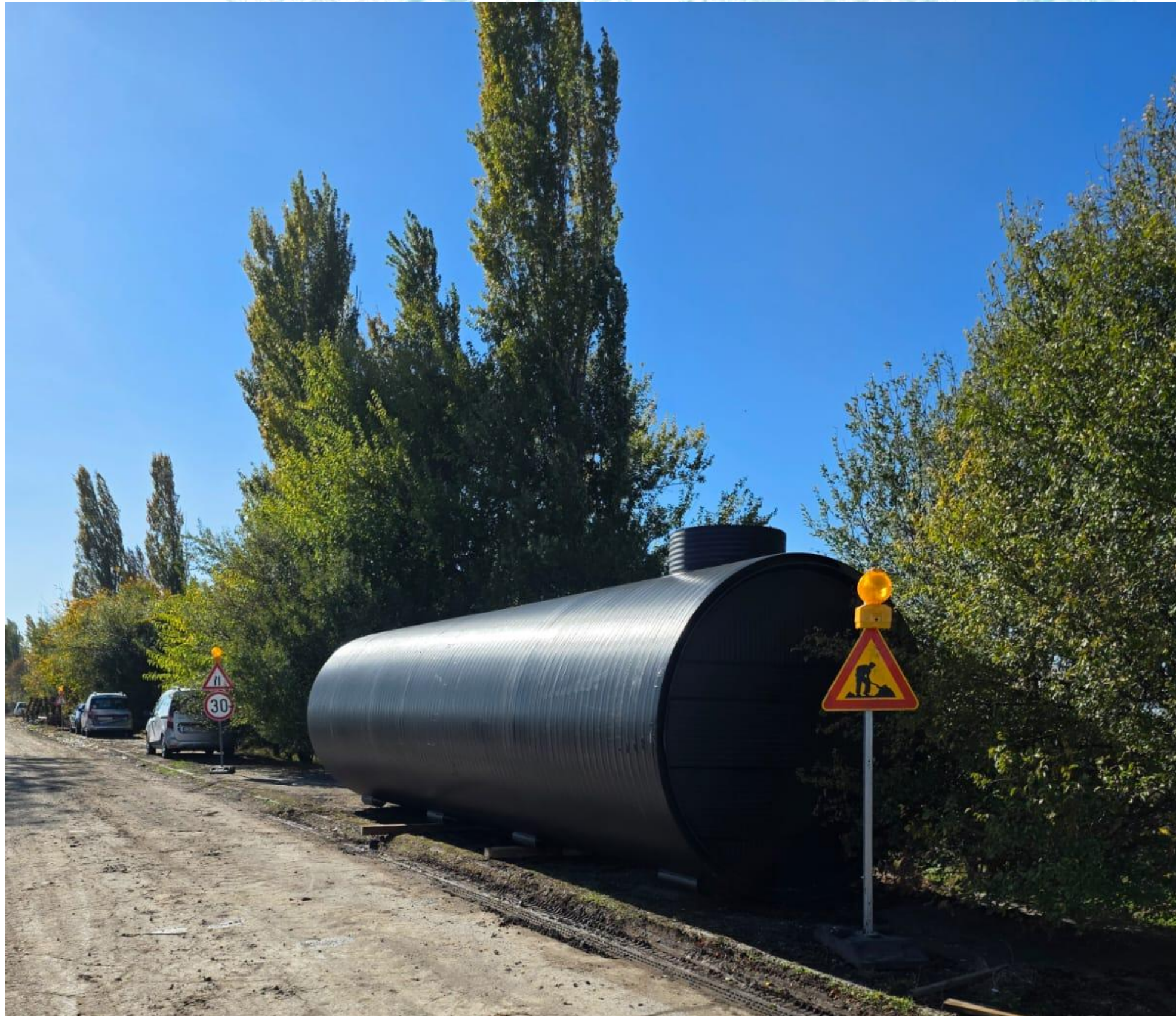
Обект: гр. Мизия, SUNOTES Резервоари за противопожарни нужди 4 \times 32\text{m}^3
