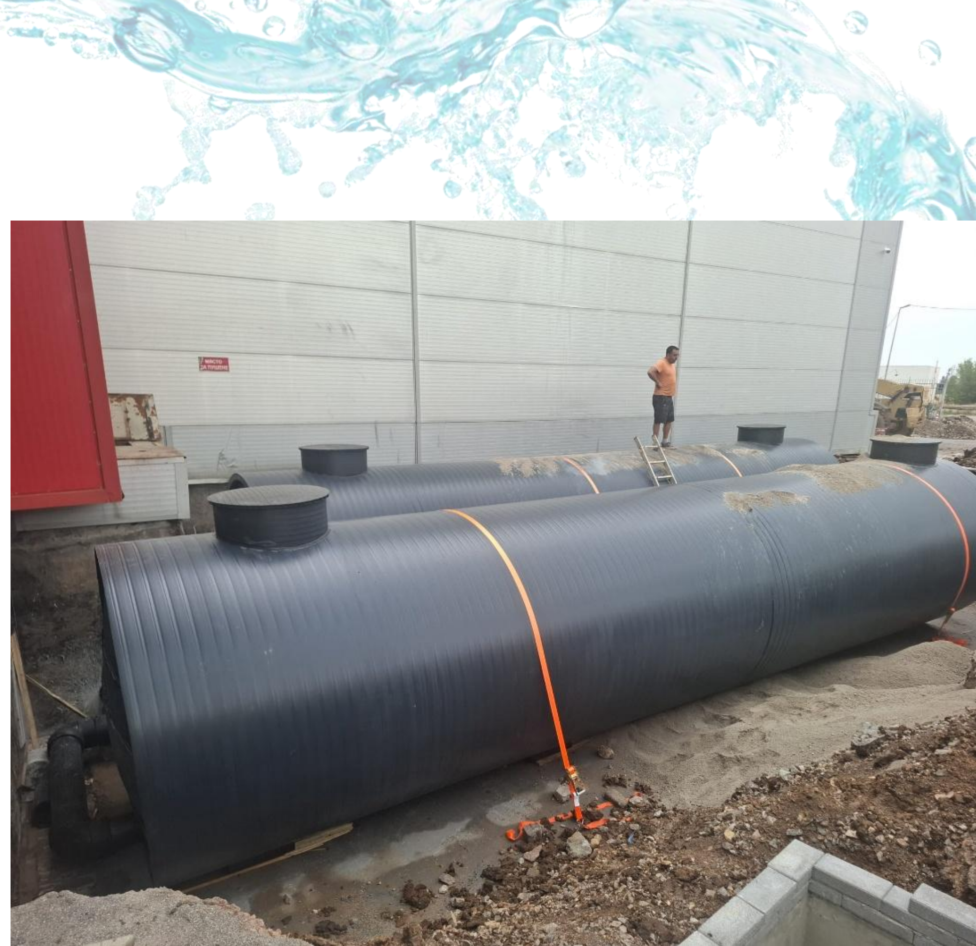
Обект: гр. София, Тексайд Резервоари за противопожарни нужди 2x50m 3
