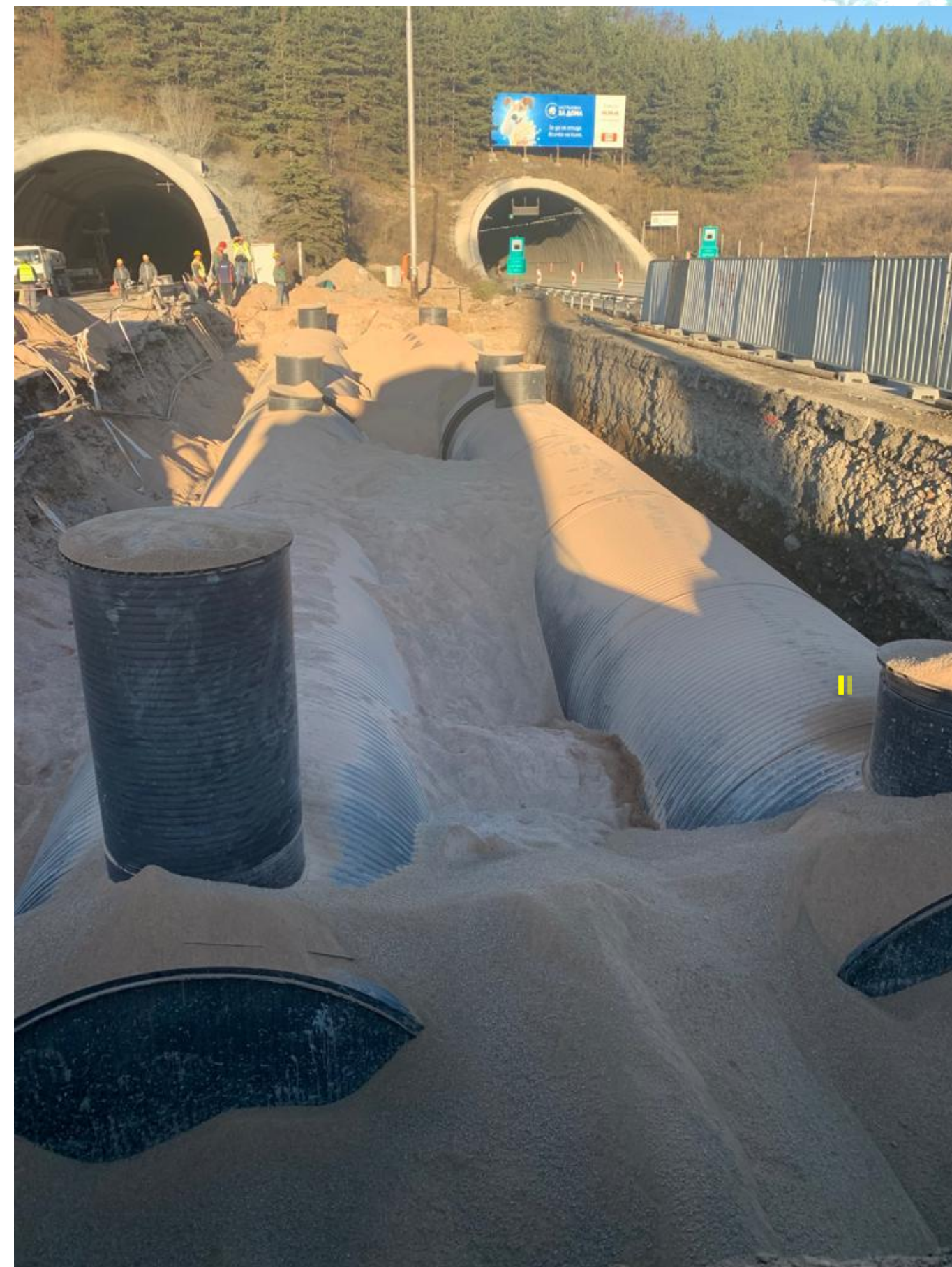
Обект: тунел Витиня Резервоари за противопожарни нужди 240m 3
