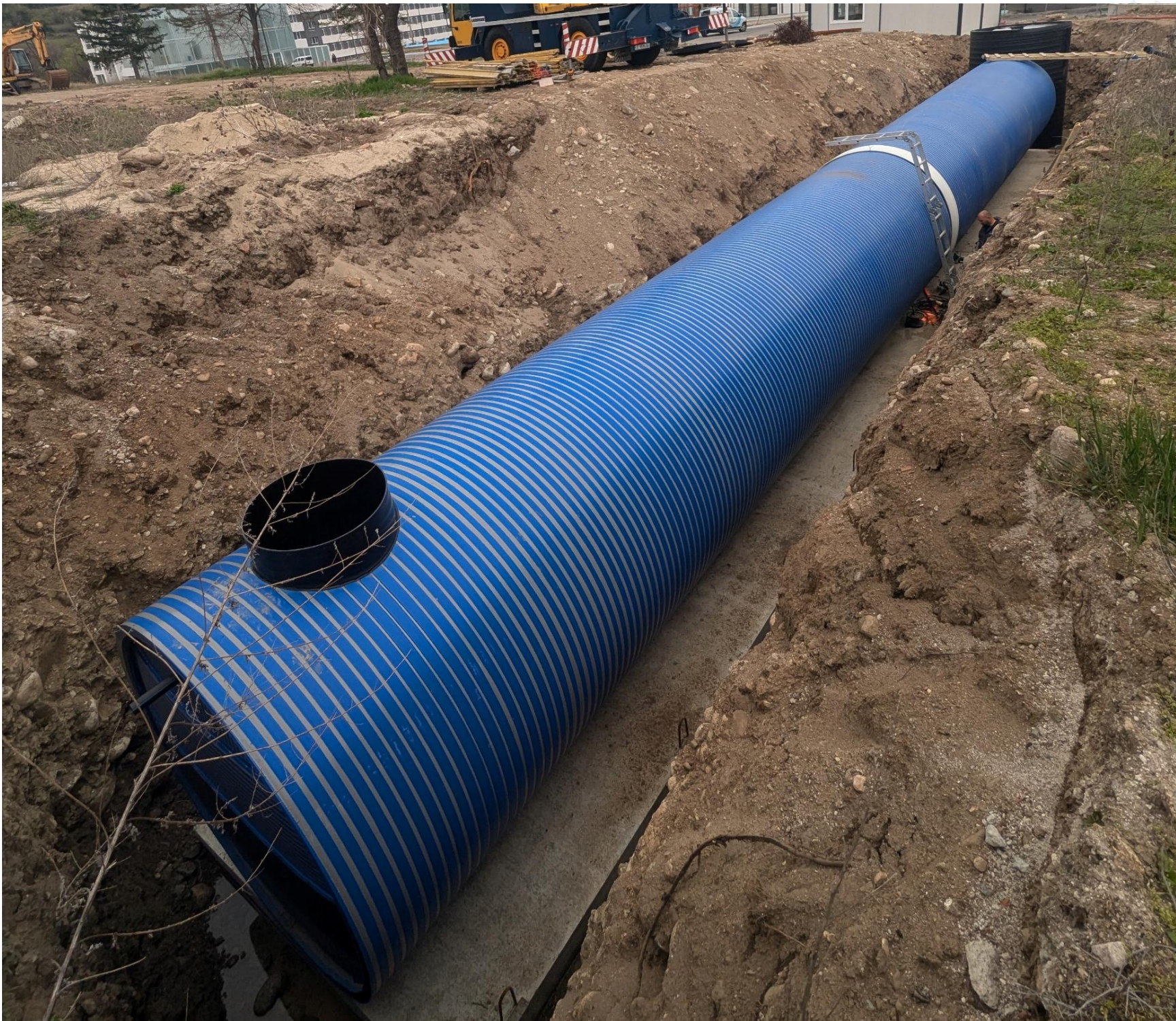
Обект: Затвор, гр. Самораново Резервоари за противопожарни нужди 100\text{m}^3 – електрозаварка на място
